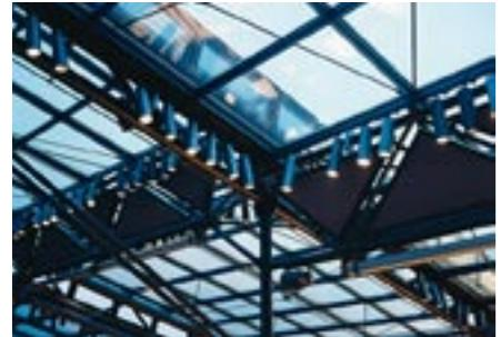
Absoluter Blendschutz war die Prämisse bei der Strahlerbeleuchtung des HOB-Centers. Die Parscan Strahler sind durch ein Wabenraster und einen verlängerten Abblendtubus modifiziert. Ihre Spotreflektoren mit 9° Abstrahlwinkel entsprechen der Serie. Sie sind mit HIT Lampen 70 bzw. 150W in der Lichtfarbe 830 warmweiß bestückt.
